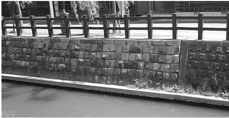
s 石材を用いて整備された護岸
