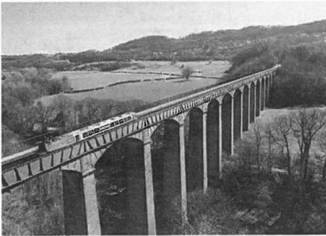
カ イギリスで見られる 水路橋を通る船舶
